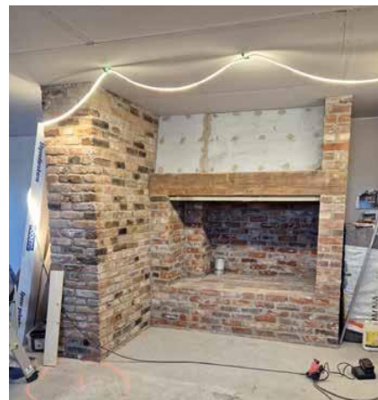
Teglstein fra de gamle pipene, som inngår i det nye ildstedet i kjelleren, er del av bærekonstruksjonen.
