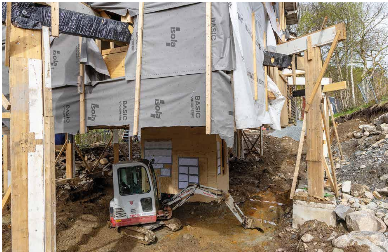
Klimabygg gravde ut ny kjeller under det svevende huset.
