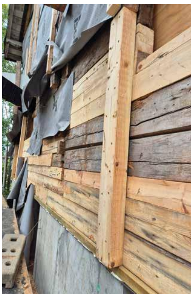
Mye av det opprinnelige trevirket var i for dårlig stand til å gjenbrukes. Det er erstattet med trevirke fra andre steder på huset, eller fra Toftegaard Trelast.
