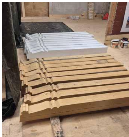
Nye taksperrprofiler laget av Klimabyggs tømre, er klare for maling.
