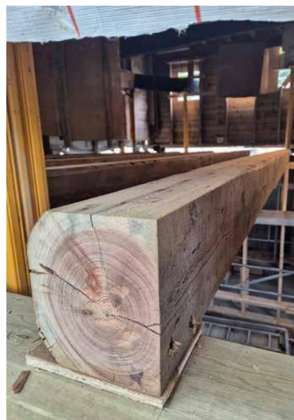
Solid gjenbruksvirke brukes til bærebjelker i 1. etasje. De går helt ut slik at ytterveggen hviler på bjelkene.
