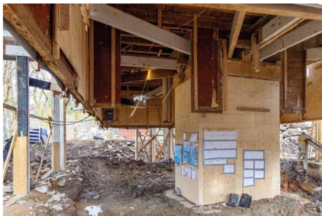
Sveitserhuset ble løftet opp fra bakken med ombrukslimtre og stod slik i fire måneder.
