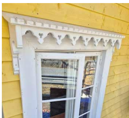
Alt listverk rundt vinduene er nye, i all hovedsak håndlaget av tømre til Klimabygg. Den forseggjorte dekoren over vinduet er det eneste som ble frest ut med Klimabygg sin CNC-fres.
