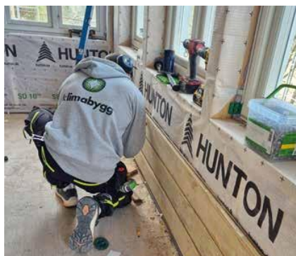
Huset isoleres med Hunton. Husets opprinnelige panel blir brukt på ny.
